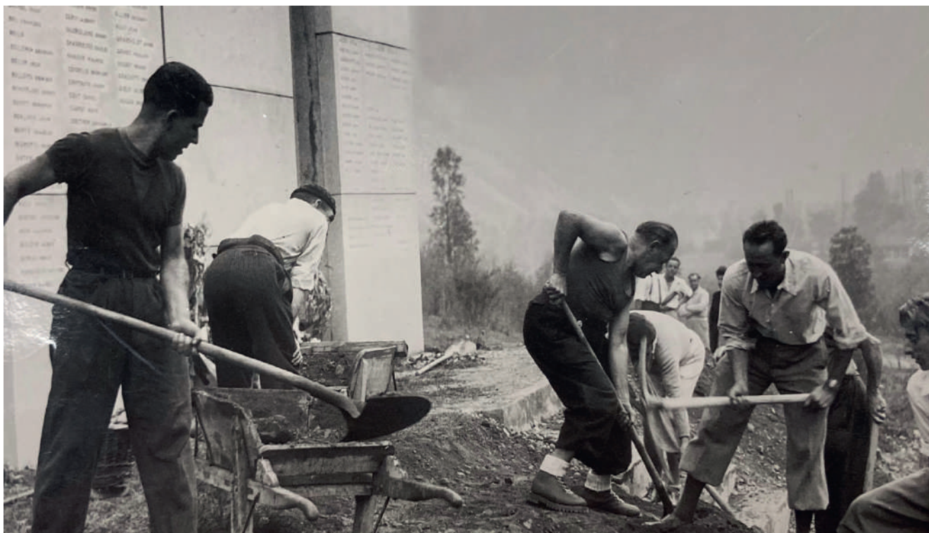
Travaux de construction et d'aménagement du monument de l'Infernet.
